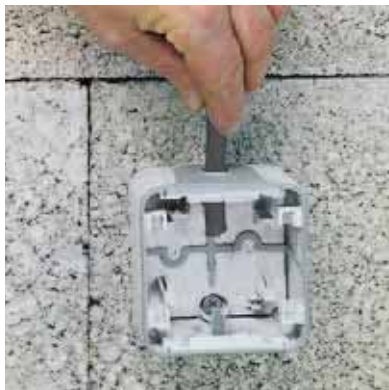
Kabel einführen
