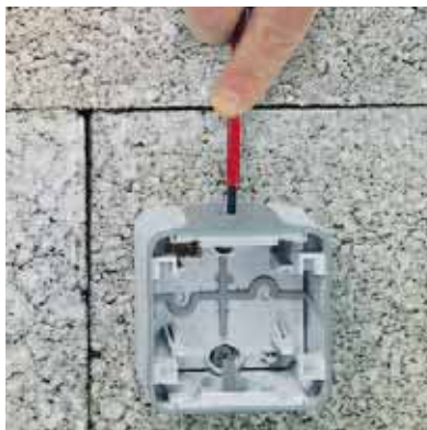
Durchstoßen der Membraneinführung mittels Schraubendreher
