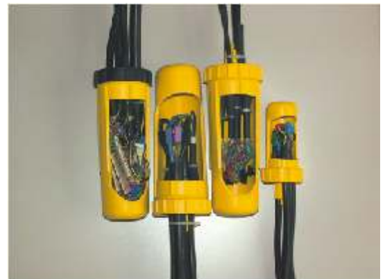
Dosenmuffen mit Telekom und Elektrokabel montiert!
